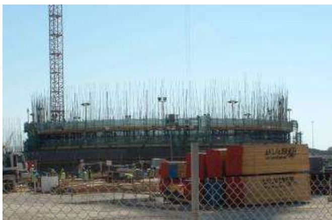
Serbatoio durante la realizzazione
