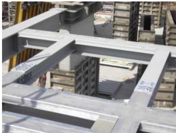
Dettaglio della carpenteria metallica dei balconi: strutture a sbalzo tirantate
