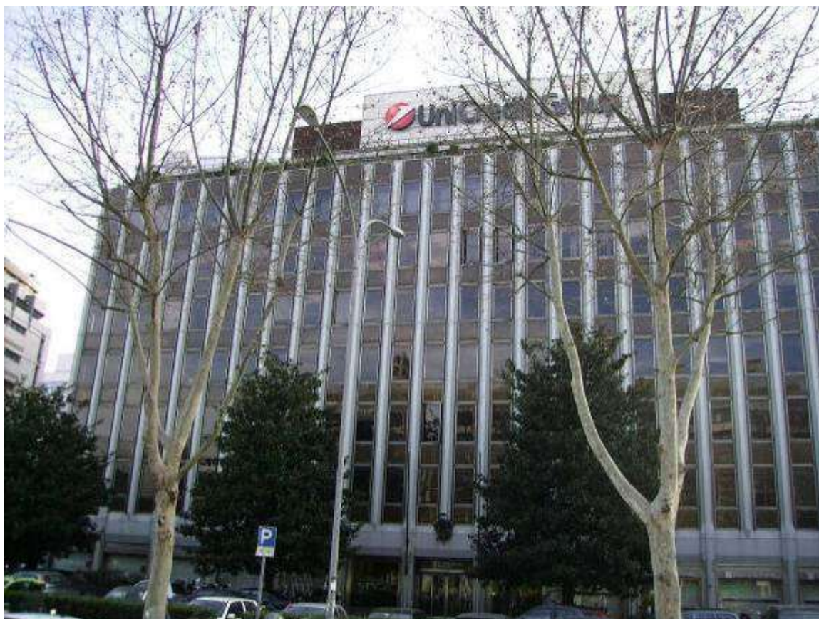
Roma – Largo Fochetti 16. Prospetto principale del maggiore dei tre edifici oggetto dell'intervento.
