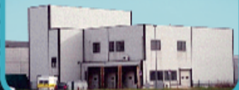
Capannone con magazzino automatizzato. Cento (Fe)
