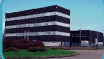
Capannone con teatro, deposito e uffici San Giovanni in P. (Bo)
